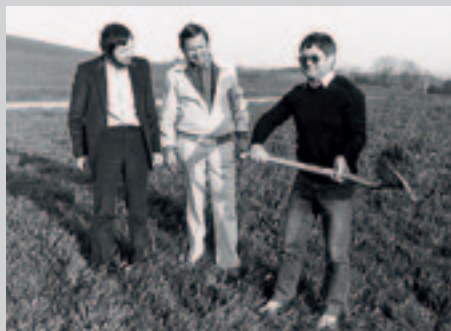
Hans freut sich über den Spatenstich des Bachtelstadion, das 1983 eröffnet wurde
